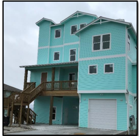
Arriba: Esta casa de buena construcción en la comunidad de Copano Village en el Condado de Aransas, TX sobrevivió al embate del Huracán Harvey en el 2017.
